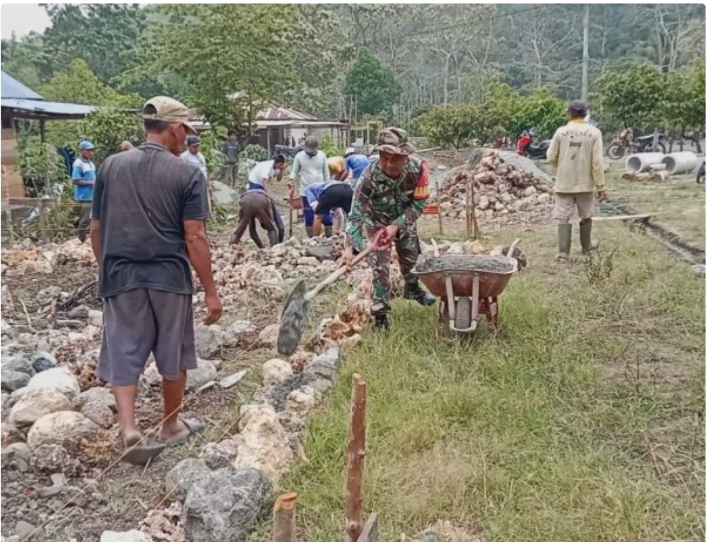
Gotong royong bangun pondasi rumah warga
